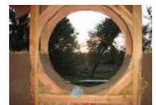
Conseil construction : faire au moins une fenêtre *en entier* avant de faire les autres : cadre, entretoises, ébrasement, planches... pr éviter de démonter-remonter.
